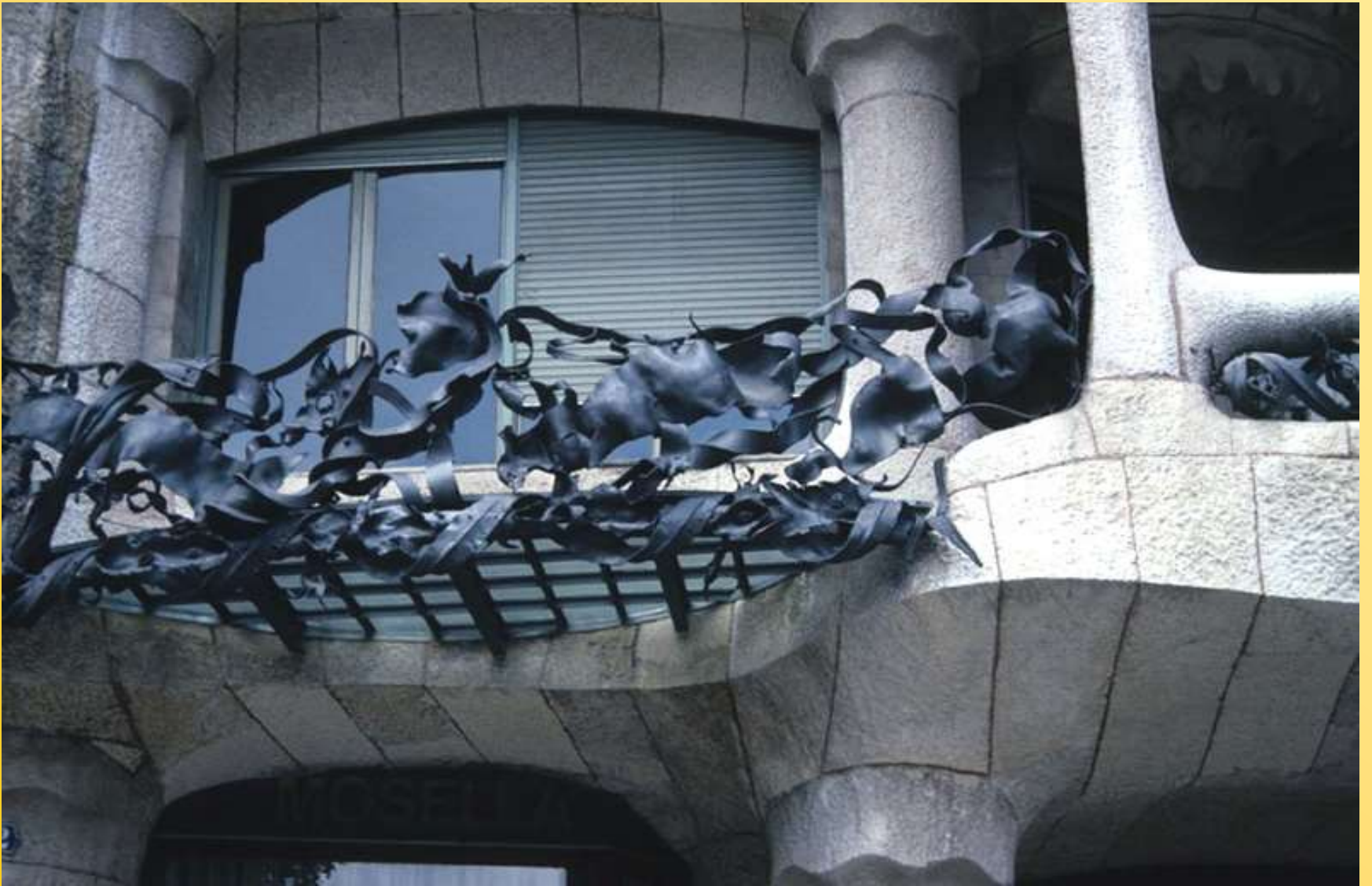
Casa Mila. Balcony. Detail
